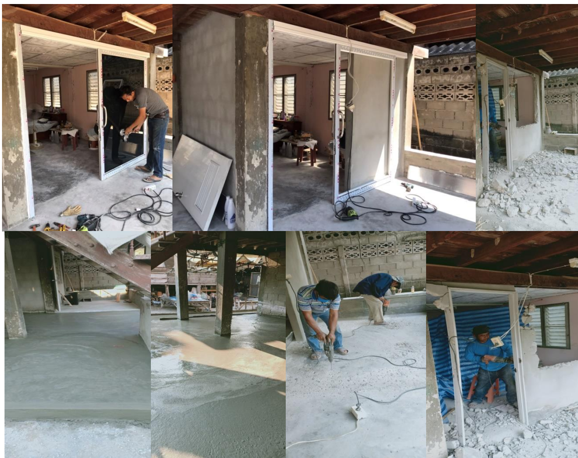
ประมวลภาพ ระหว่าง ซ่อมแซมปรับปรุงสภาพแวดล้อมที่อยู่อาศัยคนพิการ
