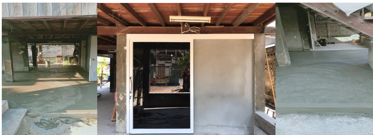
ประมวลภาพ หลัง ซ่อมแซมปรับปรุงสภาพแวดล้อมที่อยู่อาศัยคนพิการ
